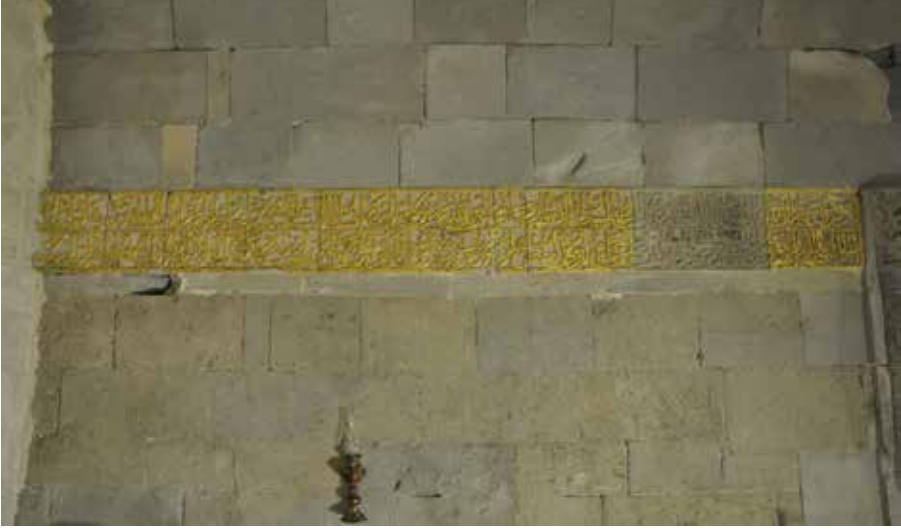
Foto. No.: 3 Batı Duvarı
